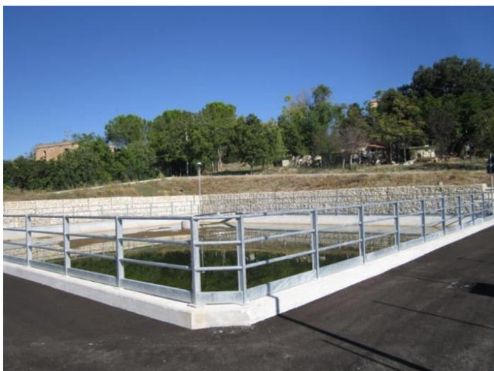
compenso e di decantazione della capacità di 1.600 m<sup>3</sup>, da una rete distributrice per uno sviluppo di 4.900 metri e dalla relativa rete comiziale.
