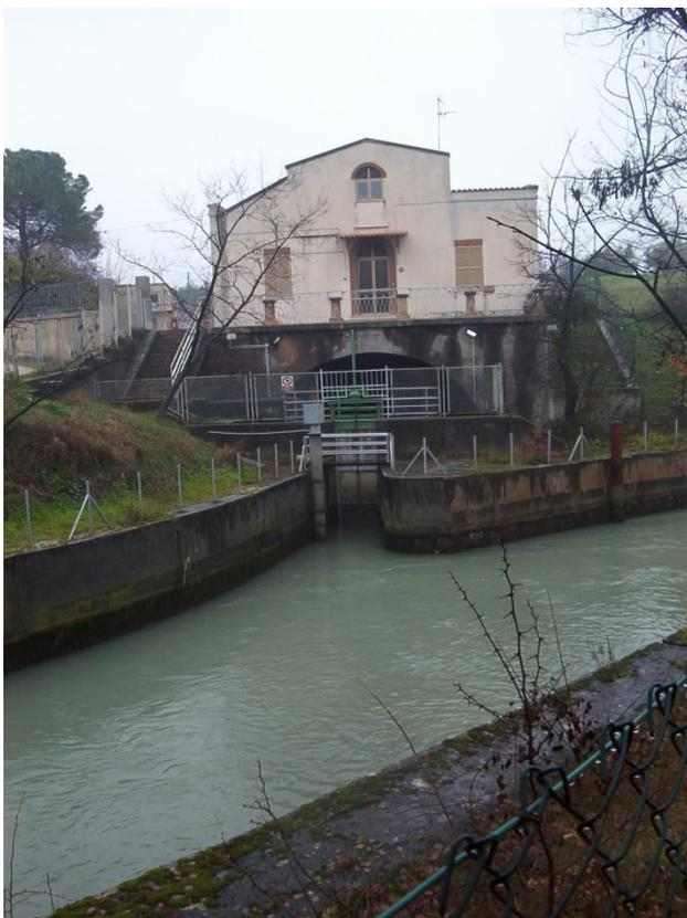
Pescara, prelevate dal canale dell'ENEL a monte della centrale idroelettrica di Alanno (3° salto). L'adduttrice principale dell'impianto irriguo è costituita da un canale scatolare lungo 19.183 metri, intercalato, lungo il suo corso, da ponti canale, gallerie, sifoni.
